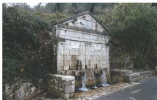
50_Η Χλια Βρύση στην είσοδο της Κοντοβάζαινας
