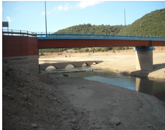
Το Γεφύρι της Κυράς και η νέα γέφυρα
