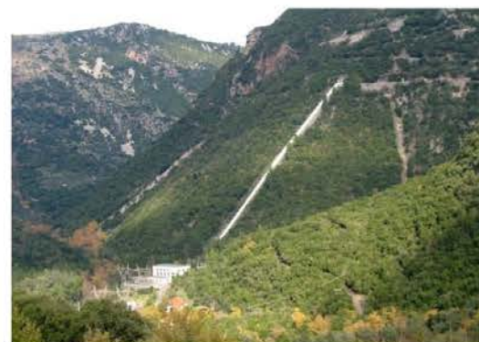
8_Οι εγκαταστάσεις του ΥΗΣ από τον Κάτω Σπάθαρη
