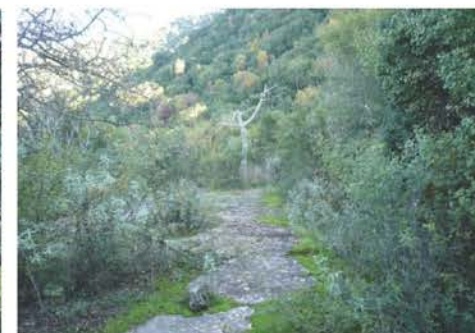
18,19_Ερείπια από την περίοδο κατασκευής του φράγματος
