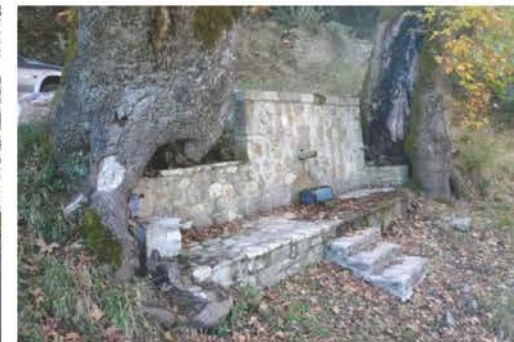
21,22_Διαμόρφωση/ αποκατάσταση κρήνης στο Κ4
