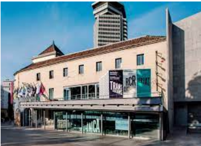
Κέντρο Τεχνών Santa Monica Βαρκελώνη, 1985-89 Albert Viaplana & Helio Pinon
