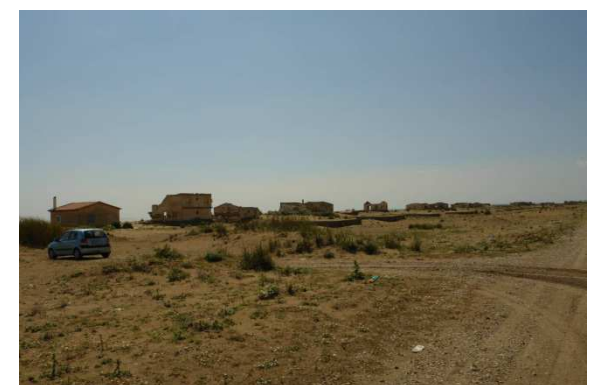
Παράνομες κατασκευές στο παραλιακό τμήμα νοτίως της εκβολής του Αλφειού
