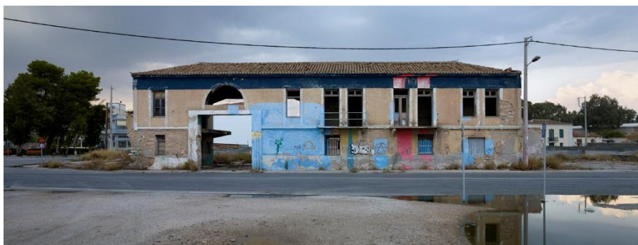
Σωζόμενο κτίριο Ελαιουργικής
