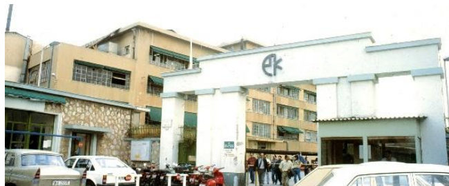
Αποθήκες ανενεργού υλικού
