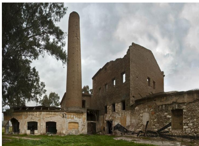
Το εργοστάσιο ΒΟΤΡΥΣ σήμερα
